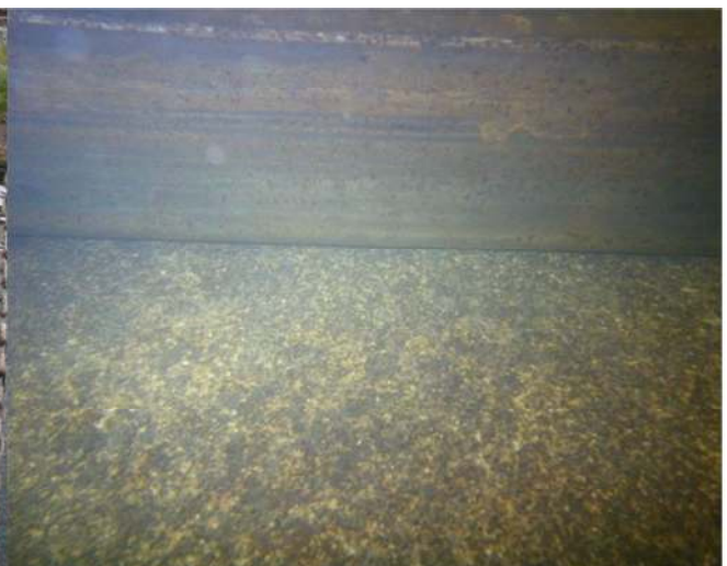
Zdjęcie 10. Widok z wody na właściwe połączenie między stelażem a betonowym dnem
