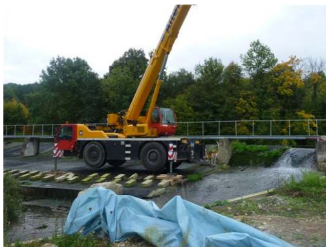
Zdjęcie 15. Dźwig przy zbiorniku
