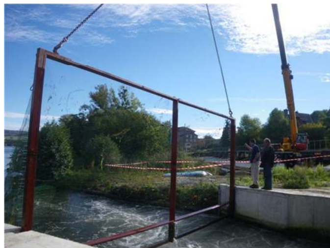
Zdjęcie 16. Montowanie stelaża za pomocą dźwigu
