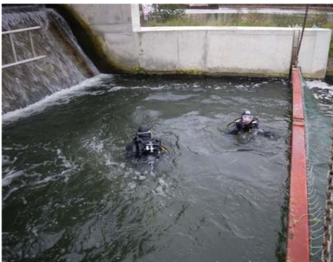
Zdjęcie 9. Nurkowie kontrolujący połączenia między betonem a stelażem
