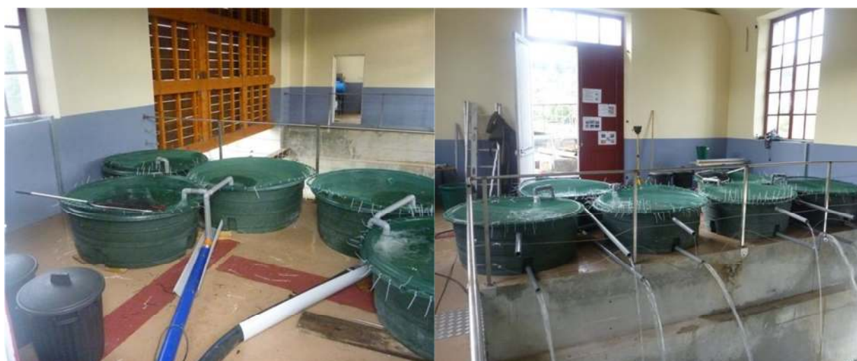
Zdjęcie 17. Widok na pięć z sześciu okrągłych zbiorników do przechowywania węgorzy
