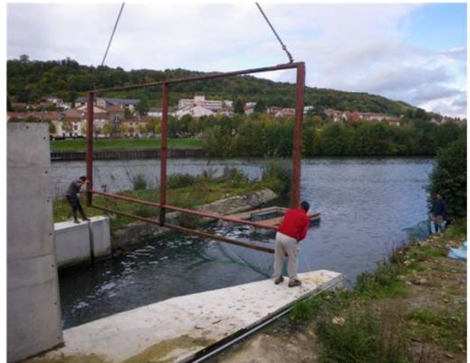
Zdjęcia 7 i 8. Stelaż podtrzymujący siatkę zamontowany za pomocą dźwigu
